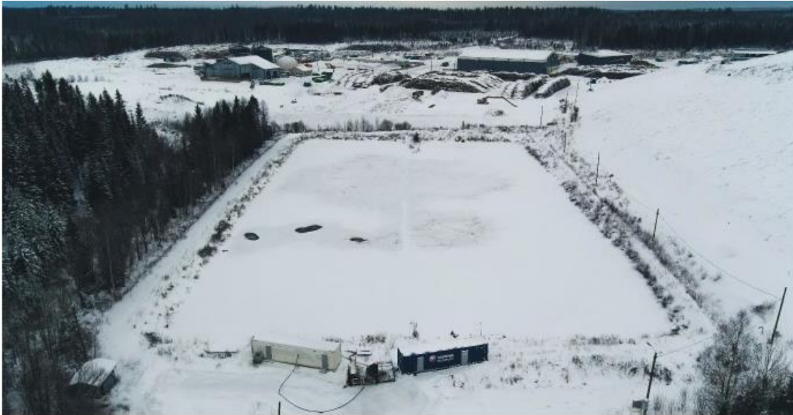
Kuva 3 Ilmakuva Jäte kukkon tasausaltaasta ja pilotointikonteista. Nykyisin kenttä- ja suotovesistä koostuva tasausaltaan vesi pumpataan pumppauskaivon kautta Kuopion veden operoimalle kunnalliselle jäteveden puhdistamolle.
