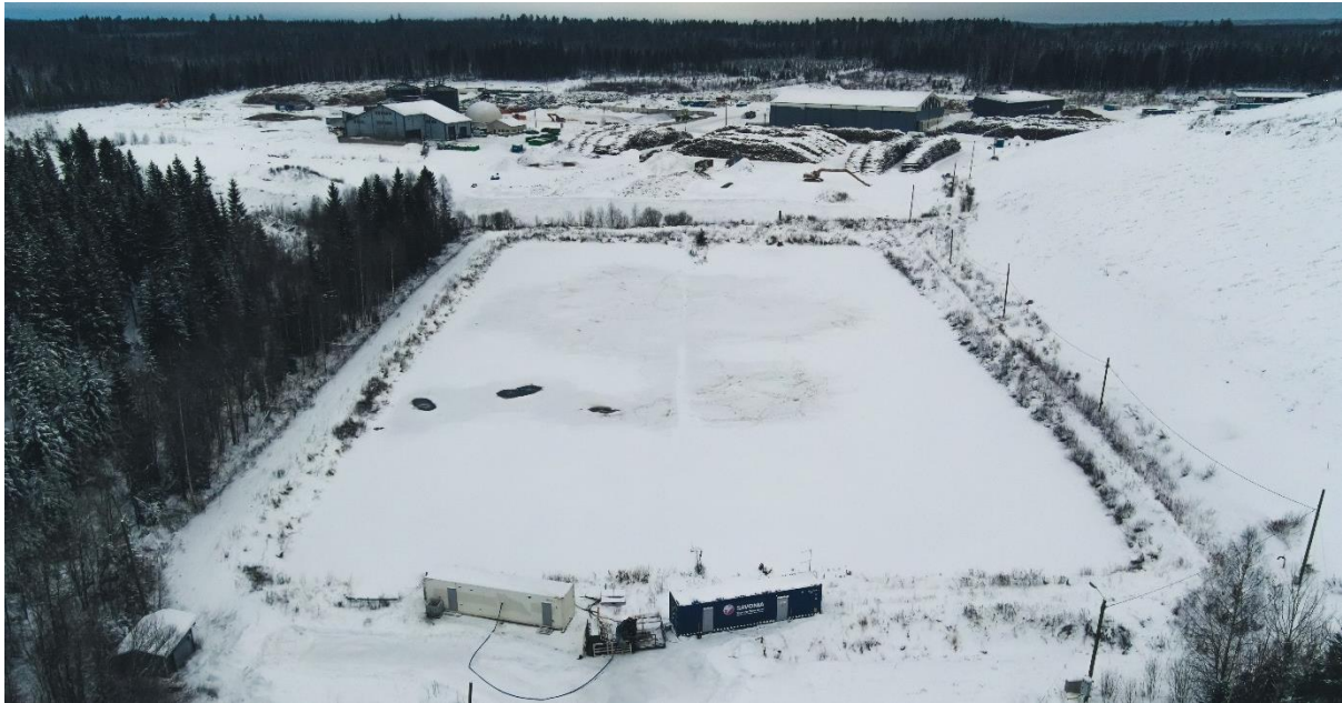
Kuva 3 Ilmakuva Jäte kukon tasaalstaan ja pilotoitinkonteista
